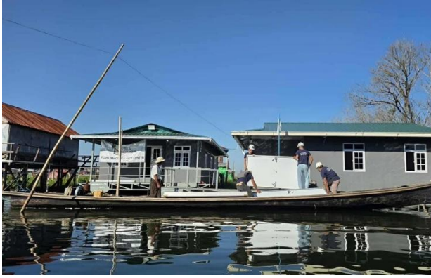
နမ့်ပန် (ရေလယ်) ကျေးရွာတွင် အခြေစိုက်တည်ရှိသော ရေပေါ် သဘာဝဘေးဒဏ်ခံအဆောက်အအုံ နှစ်ဆောင်။
